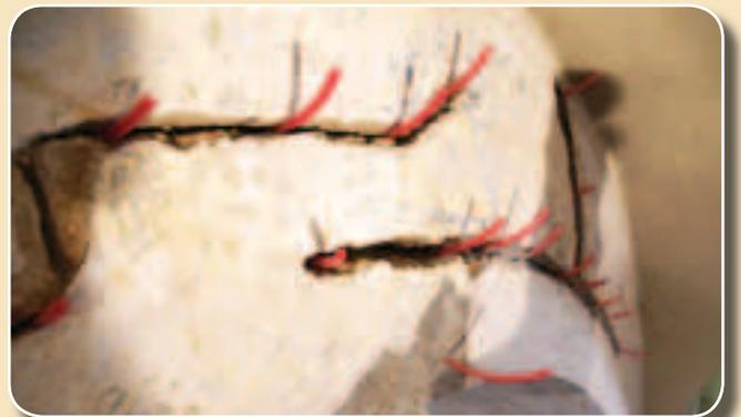
Mit Hilfe der Schläuche werden tiefgehende Risse im Mauerwerk mit Fließmörtel ausgegossen.
