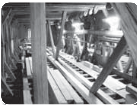
Jede Menge zusätzlicher Holzbauteile werden den Dachstuhl verstärken.
